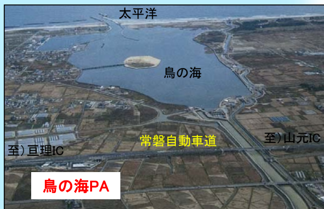
完成した常磐自動車道 鳥の海PA
