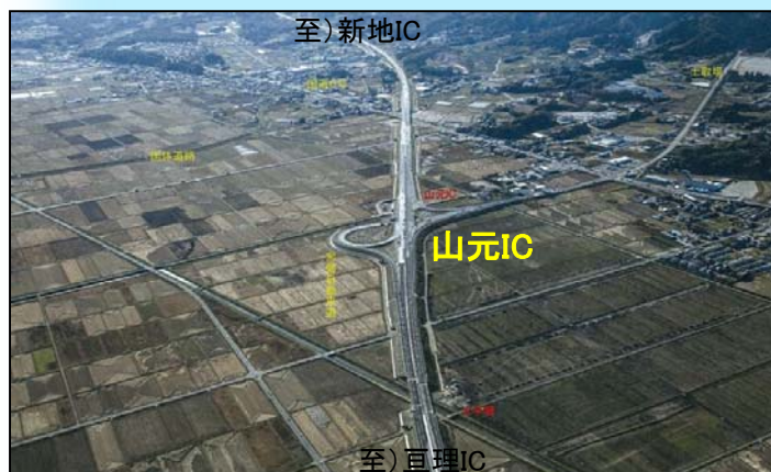
完成した常磐自動車道 山元IC
