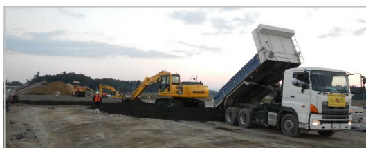
堤防工事への再生土砂搬入状況
