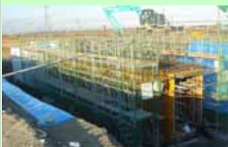
山元IC施設工事状況
