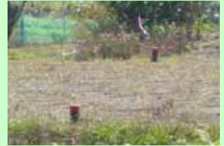
幅杭の打設状況
