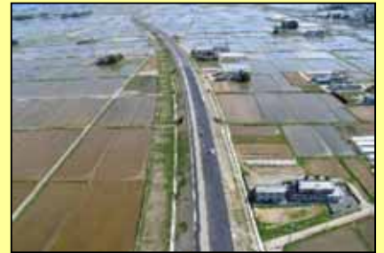
舗装工事真最中
